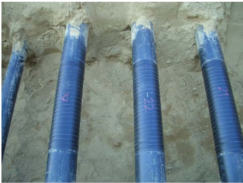
Oberes Bild: nachisolierte Rohrleitungen nach Ultraschallmessung Unteres Bild: Ultraschallmessung durch die industrielle Isolation
