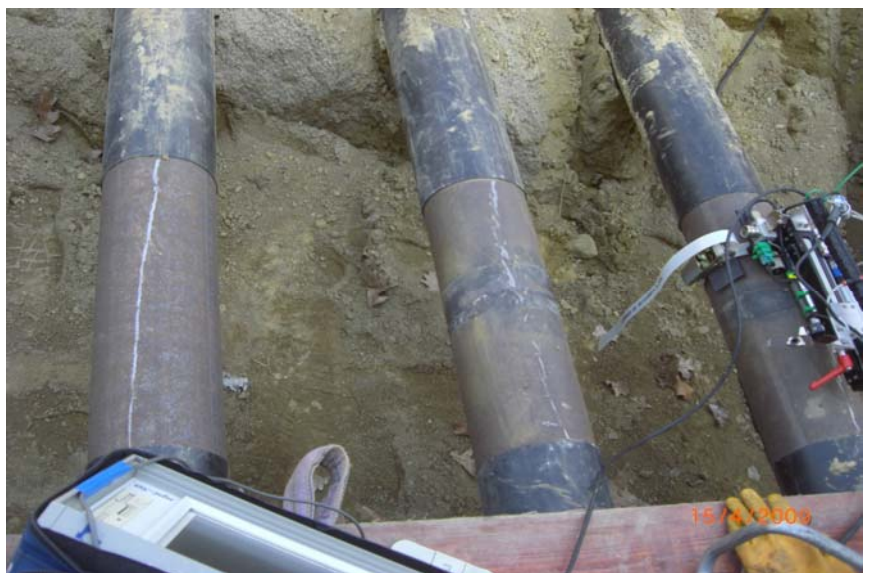
Bild unten: Prüfgrube mit zur Messung vorbereiteten Rohrleitungen mit aufgesetzten automatischen 360°-Ultraschall-Messgerät
