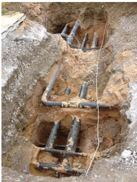
Rohrleitungsfreilegung zur Prüfung
